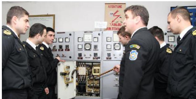
Cabinet mașini și instalații electrice
